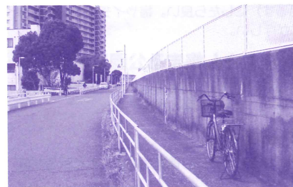
◀正蓮寺川を高さ 1.6 ~ 2m のコンクリート壁が囲っている
