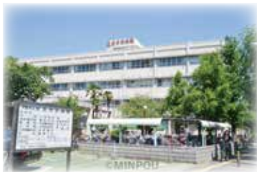
解体工事が始まっている 住吉市民病院(住之江区)
